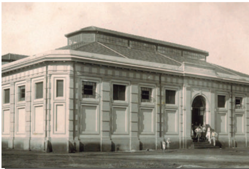
Mercadão antes do incêndio - vidros estavam quebrados
