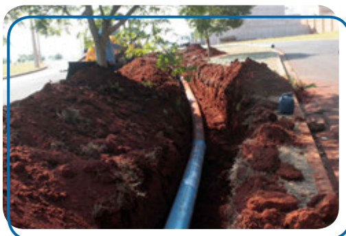
Construção de 24 quilômetros de redes adutoras
