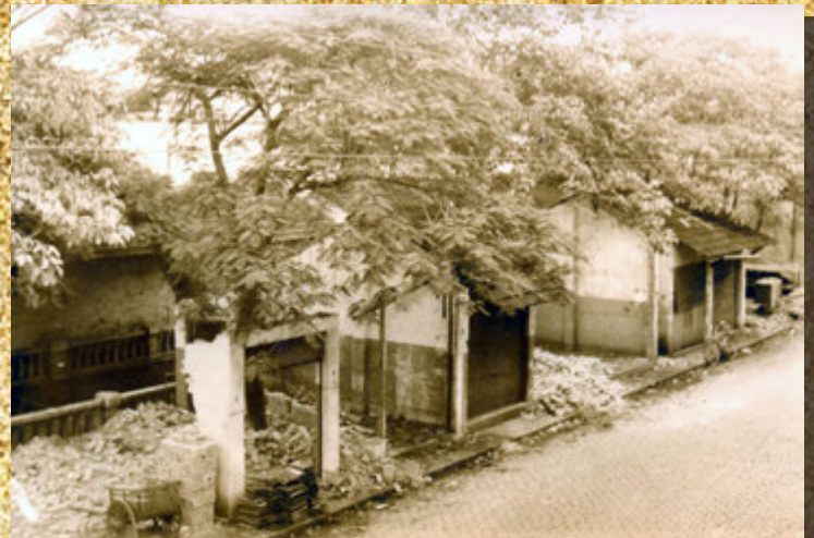
Demolição de bancas de frutas e verduras na av. Jerônimo Gonçalves
