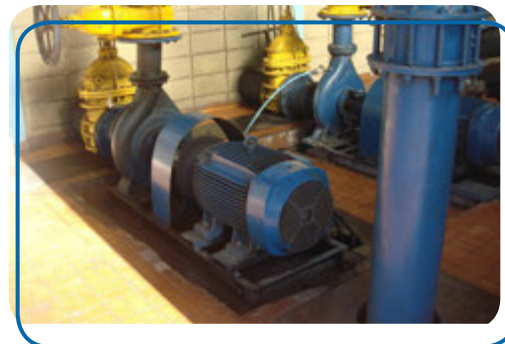
Construção de 7 Estações Elevatórias de Água Tratada
