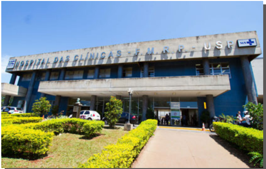
Prédio do HC no campus USP foi inaugurado em 1978
