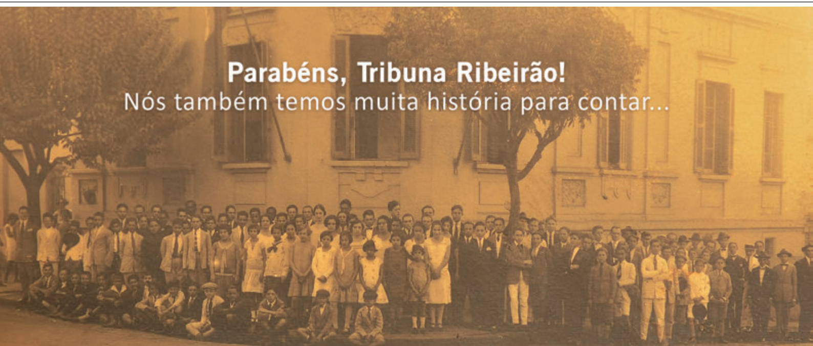
Instituto Commercial de Ribeirão Preto. Rua Lafaiete, ca. 1923
