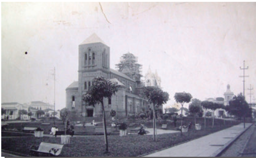
Catedral de São Sebastião na fase final de obras
